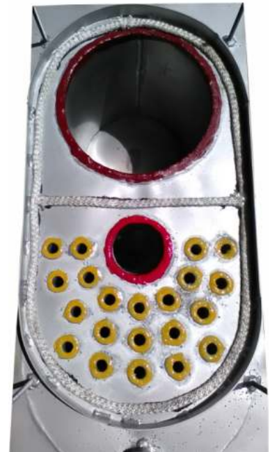
Θάλαμος καύσης επάνω, φλογαυλός 2ης διαδρομής (κάτω κόκκινος) και φλογαυλοί τρίτης διαδρομής
