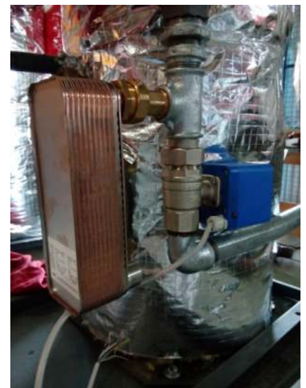
Πλακοειδής εναλλάκτης παραγωγής ζεστού νερού χρήσης
