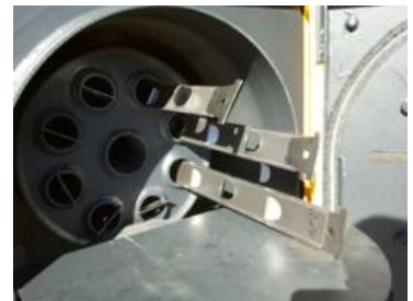
Κυλινδρικός εναλλάκτης με φλογοαυλούς
