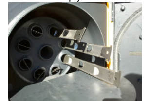
Κυλινδρικός φλογαυλωτός εναλλάκτης με στοβιλιστές
