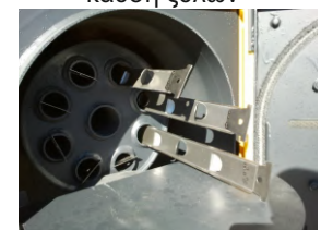
Κυλινδρικός φλογαυλωτός εναλλάκτης με στοβιλιστές
