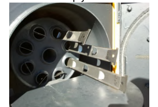
Κυλινδρικός φλογαυλωτός εναλλάκτης με στοβιλιστές
