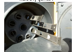
Κυλινδρικός φλογαυλωτός εναλλάκτης με στοβιλιστές
