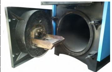
Κάτω πόρτα με τοποθετημένο τον καυστήρα PV-350 με δευτερογενή αέρα καύσης και κινούμενες σχάρες οι οποίες καθαρίζουν από τη στάχτη αυτόματα
