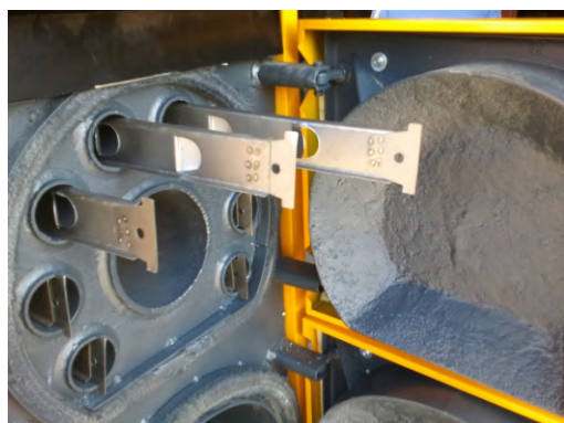
Δεύτερη διαδρομή καυσαερίων (κέντρο) και φλογαυλοί τρίτης διαδρομής με στροβιλιστές καυσαερίων
