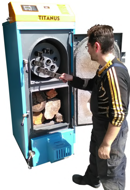
Κυλινδρικός εναλλάκτης επάνω από το θάλαμο καύσης με στροβιλιστές καυσαερίνων
