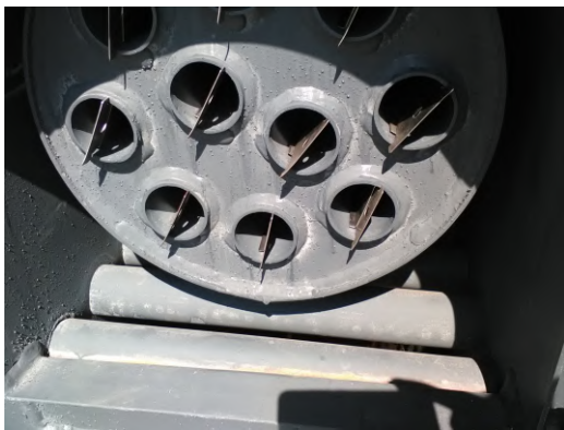
Κυλινδρικός εναλλάκτης επάνω από υδραυλικούς οι οποίοι αυξάνουν τη θαιρμενόμενη επιφάνεια και το βαθμό απόδοσης
