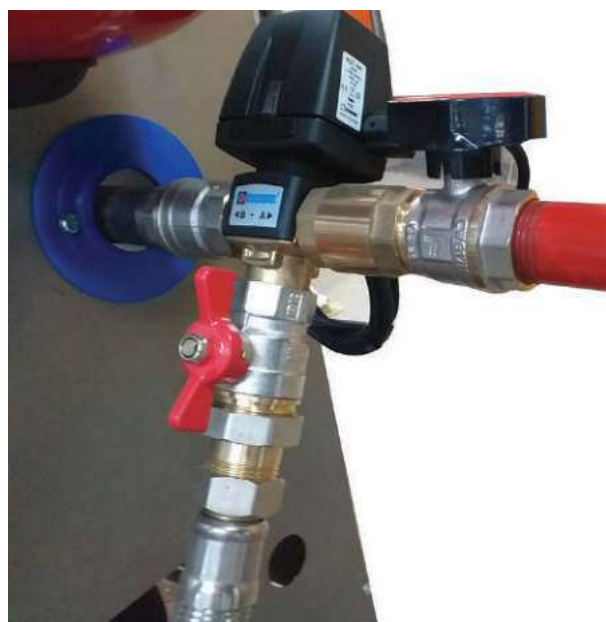
Κιτ ανακυκλοφορίας με βάνα εκτροπής
