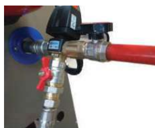
Κιτ ανακυκλοφορίας με βάνα εκτροπής
