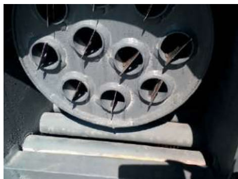
Κυλινδρικός εναλλάκτης επάνω από υδραυλούς οι οποίοι αυξάνουν τη θαιρμενόμενη επιφάνεια και το βαθμό απόδοσης
