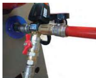
Kit ανακυκλοφορίας με βάνα εκτροπής
