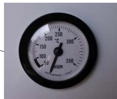
Πυρόμετρο καυσαερίων, μετράει τη θερμοκρασία τους στην έξοδο του λέβητα, πριν εισέλθουν στον εναλλάκτη συμπύκνωσης
